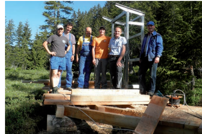
Beim Bau einer Station des Silberpfades durch die Seilbahnangestellten und Mitarbeiter des Bauhofes.
