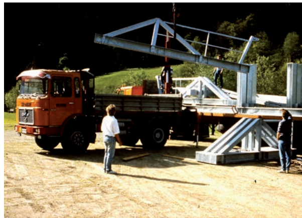
Stützenteile werden antransportiert ...
