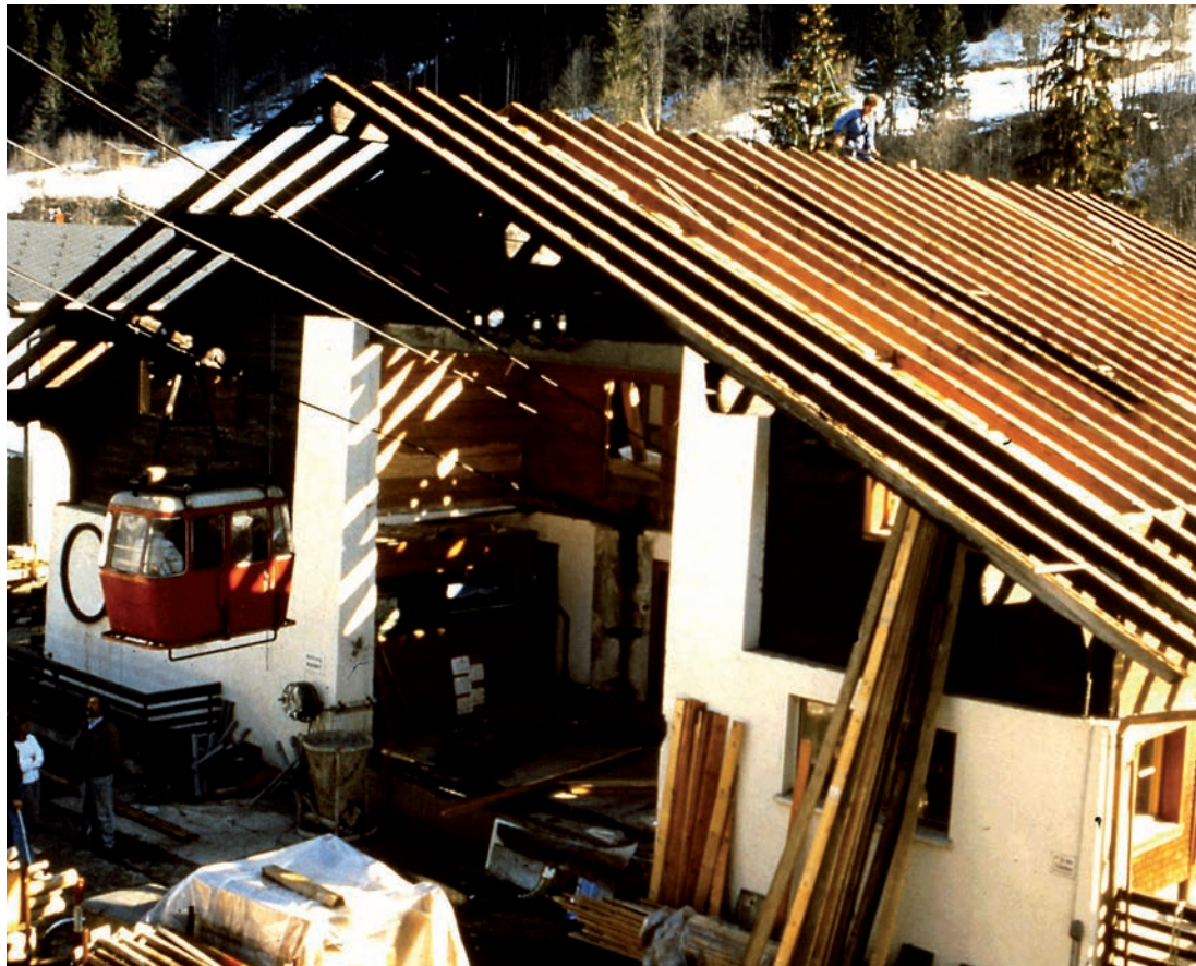
Der Abbruch beim Gebäude hat begonnen.
