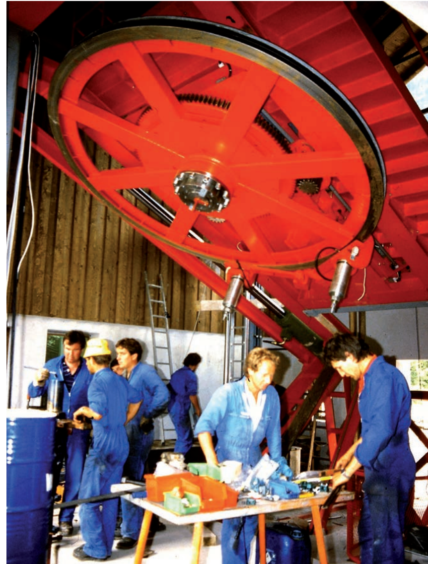
Die Antriebsscheibe ist eingebaut.
