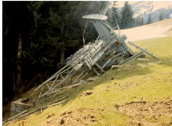
Die abmontierte Stütze im Bereich Stelza.
