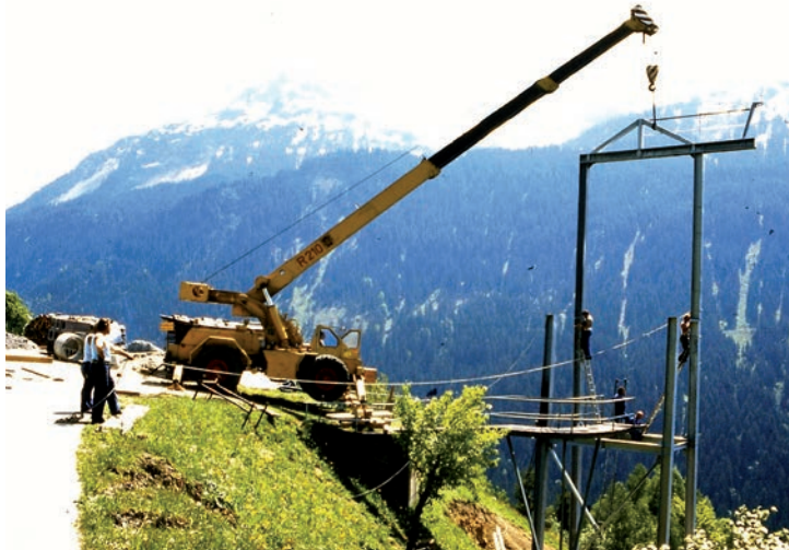
Der Zusammenbau der Stütze „Schöni“.
