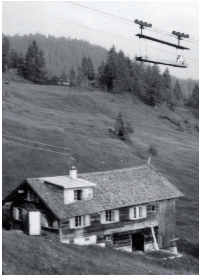
Alte Materialeseilbahn auf dem Kristberg, erbaut in den Jahren 1941 und 1942. Mit dieser Bahn wurden auch Personen befördert.
