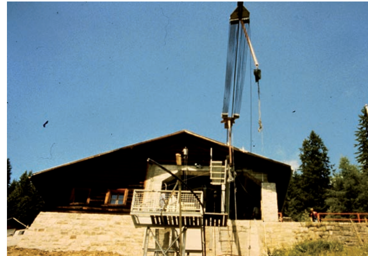
Der Treppenabgang bei der Bergstation ist ebenfalls fertiggestellt.
