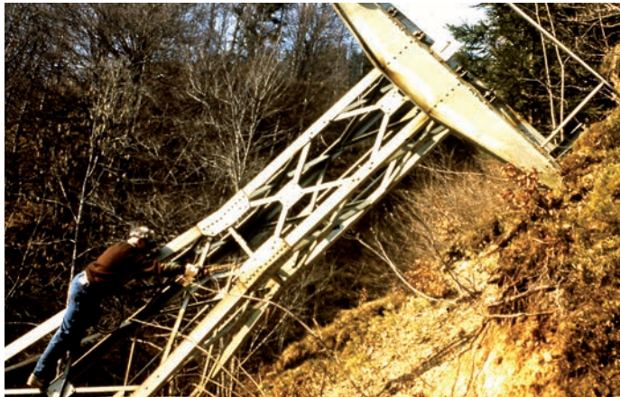
Die Stütze beim Abtrag im Bereich „Stutz“.
