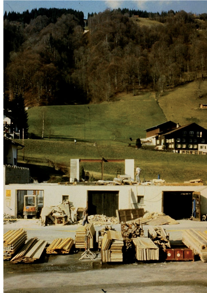
Das Gebäude der Talstation wird bis auf die Grundmauern abgetragen.
