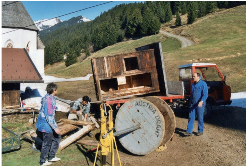
Die Teile des unteren Schlepliftes beim Abtransport.
