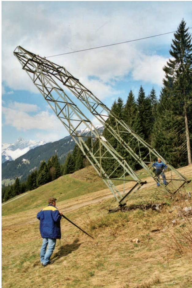
Abbruch des alten Kristbergliftes im Jahre 2002.
