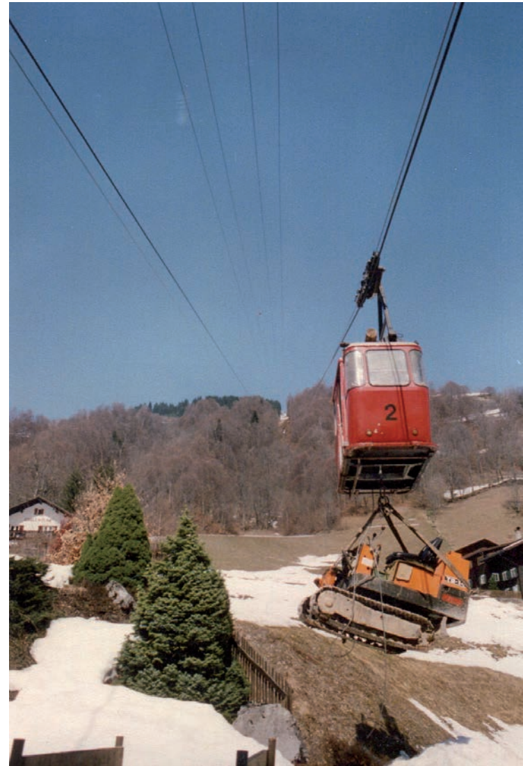
Einer der letzten Materialtransporte, eine Raupe wird zur 1. Stütze transportiert.
