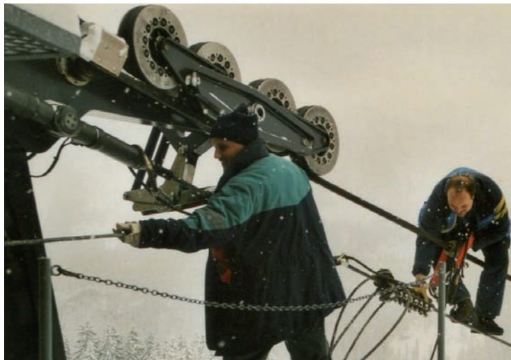
... und die laufenden Revisionsarbeiten bei der Bahn.
