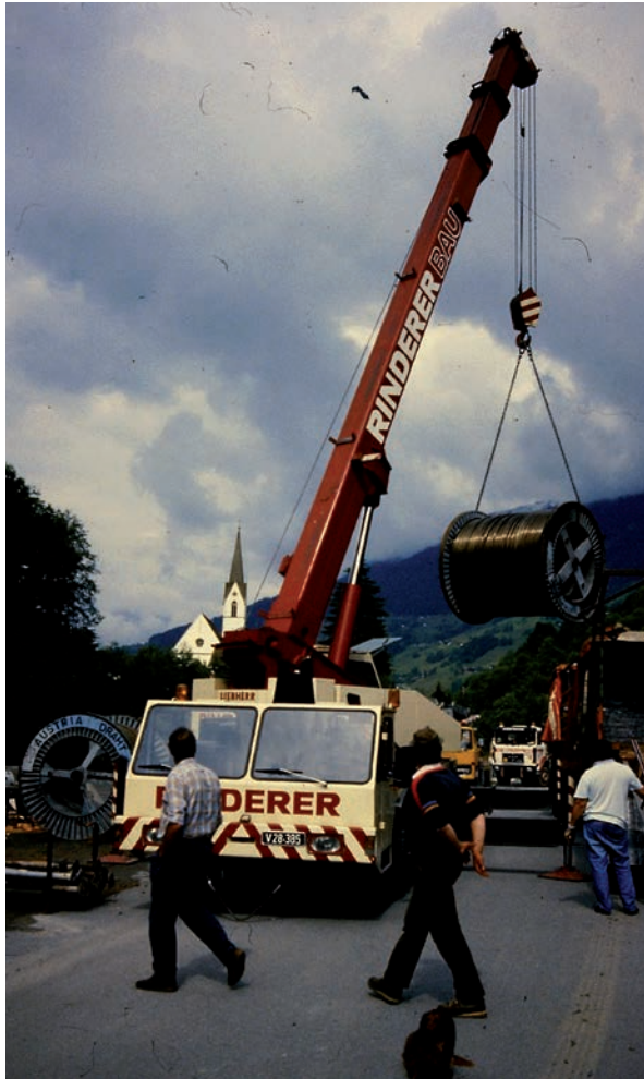
Die Fa. Rinderer bei der Entladung einer Seilrolle mit dem Telekran.
