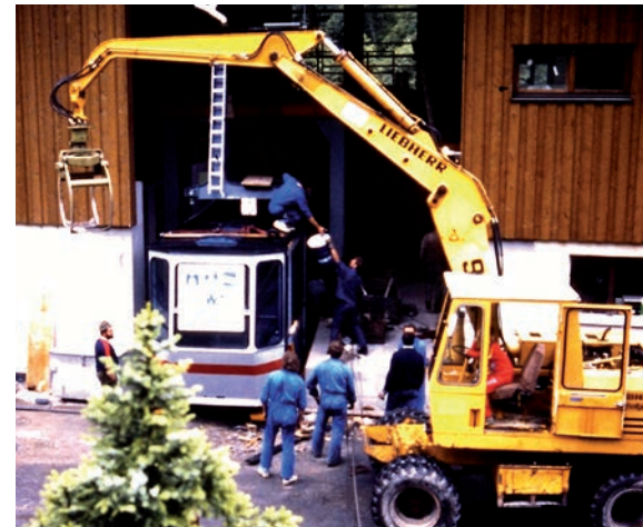
Die Gondel wird an das Laufwerk montiert.
