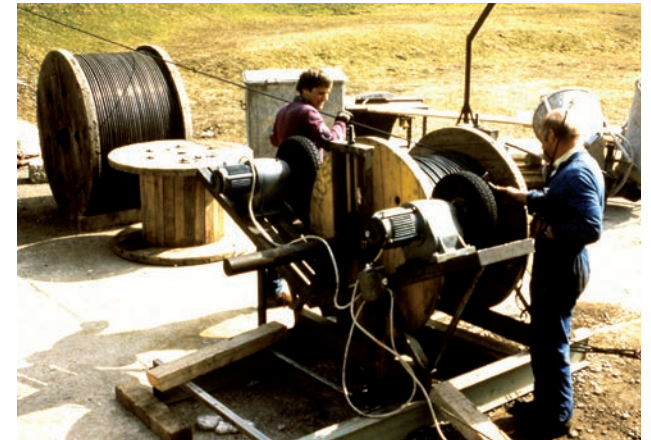
Ein altes Tragseil wird aufgerollt.
