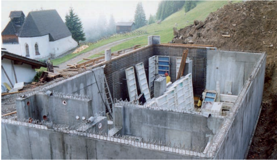
Bau vom Wasserspeicher für die Beschneigung und Trink- und Löschwasserreservoir.
