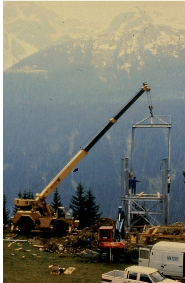
Mittels Telekran wurden die einzelnen Teile zusammgebaut.
