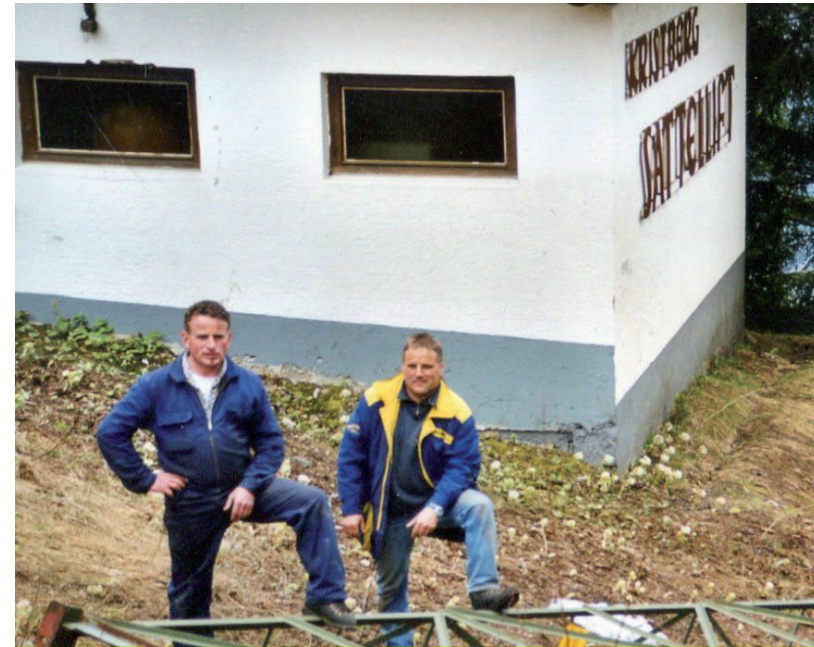
Erwin Ganahl (li.) und Günter Säly bei Abbrucharbeiten am Sattelift.
