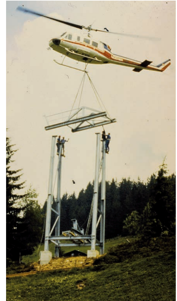
Beim Aufsetzen des Stützenoberbauteiles bei Stütze 4.
